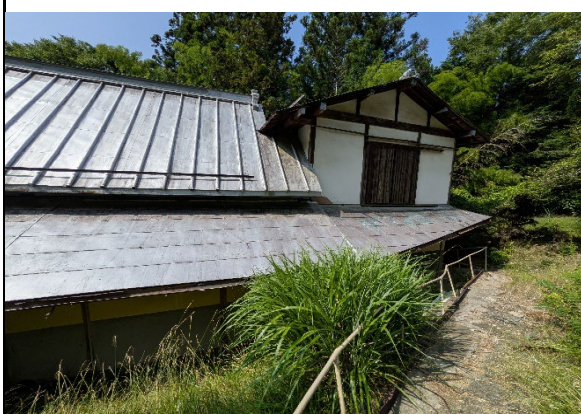
建物外観(北面)
