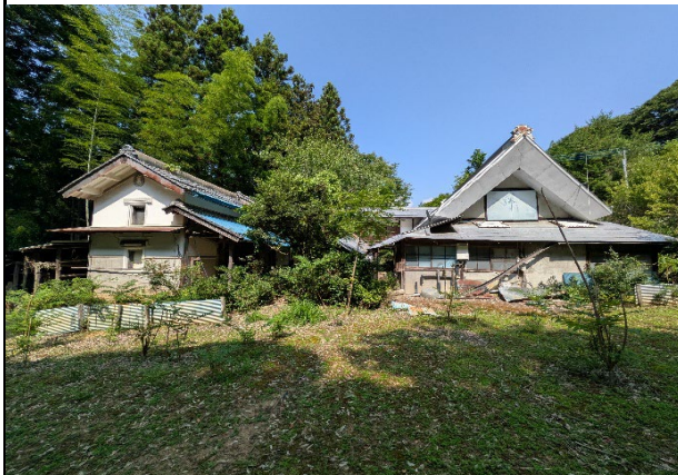
建物外観(東面)
