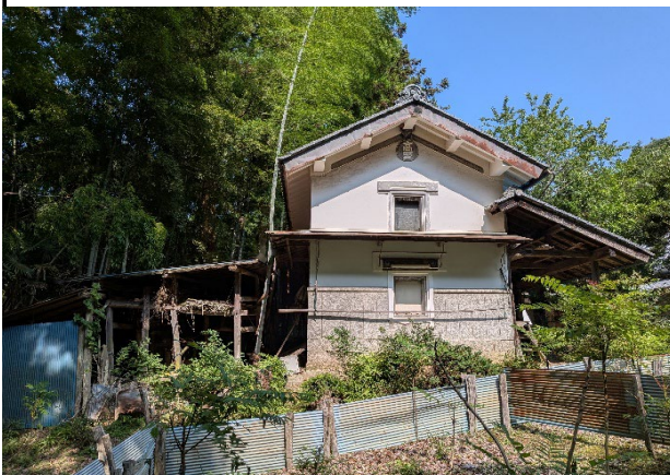
離れ土蔵外観(東面)
