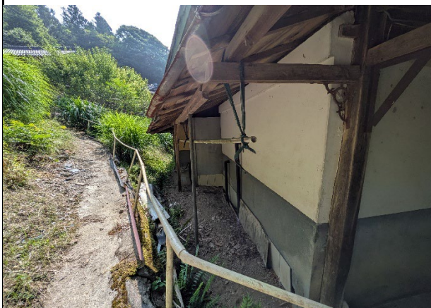
建物外観(北西面)
