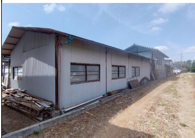
付属棟 農機具用車庫兼倉庫(1階CB造・2階S造+S造平屋)
