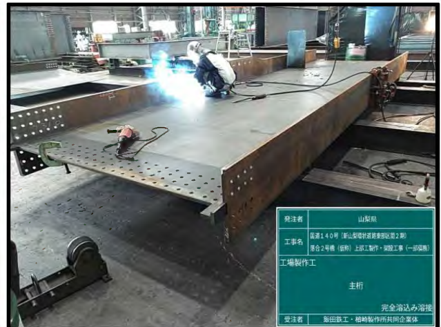
橋桁製作状況
