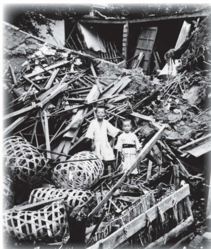
倒壊した家屋(都留市内)
