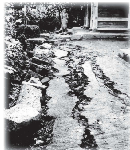
円通院山門付近の地割れ(都留市内)
