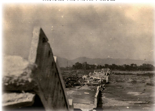
酒匂川国道の橋(神奈川県)
