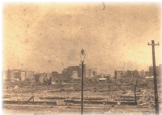
東京駅前の焼け跡、日本橋方面
