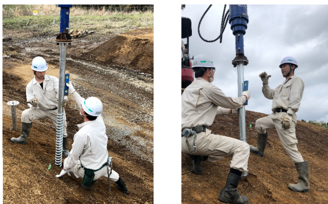
(a) スクリュー杭の施工例（回転貫入）
