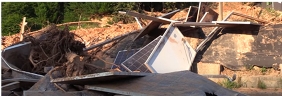
写真 2-1 傾斜地設置型太陽光発電設備の豪雨被害事例（1）写真提供：PVeye
