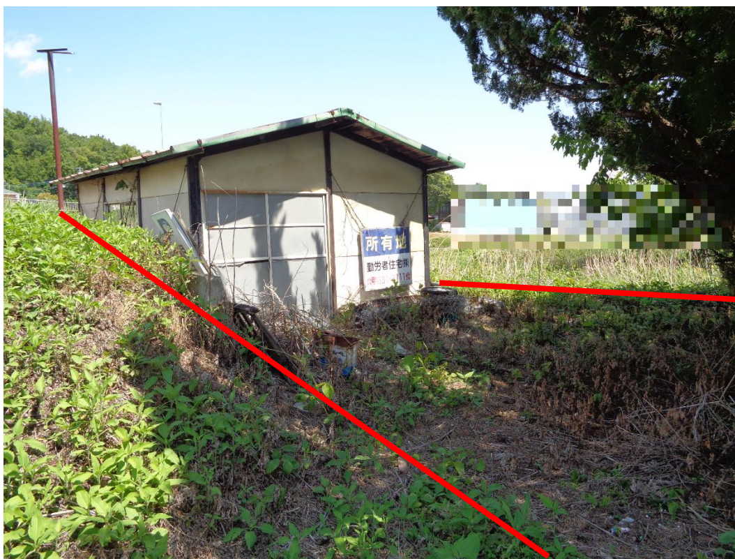
対象物件西側から東方向を撮影（赤線は隣地とのおおよその境界）
