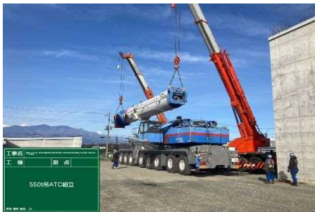
550t吊クレーン組立
