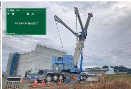
550t吊クレーン組立完了
