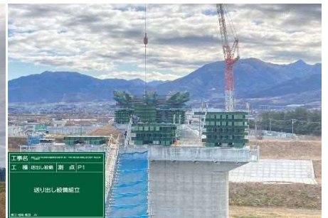
P1送出し設備組立
