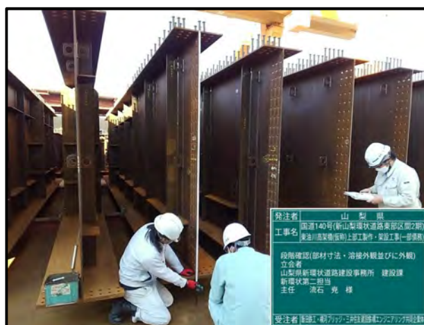
橋桁検査状況
