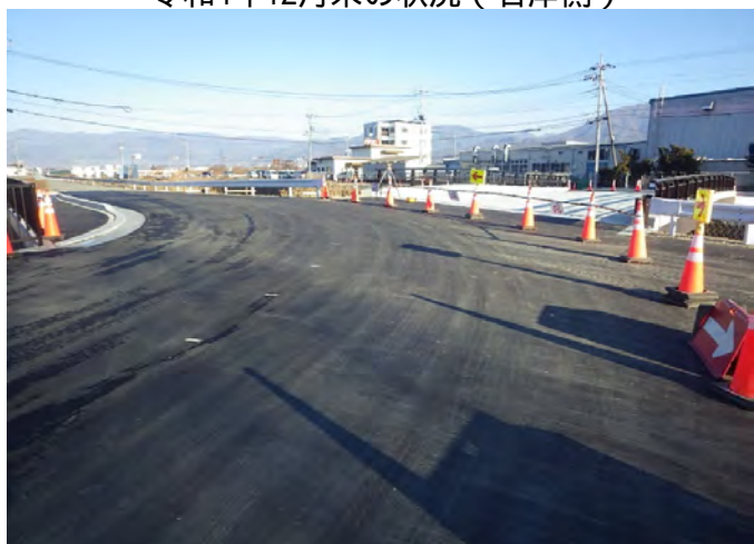
令和4年12月末の状況（右岸側）
