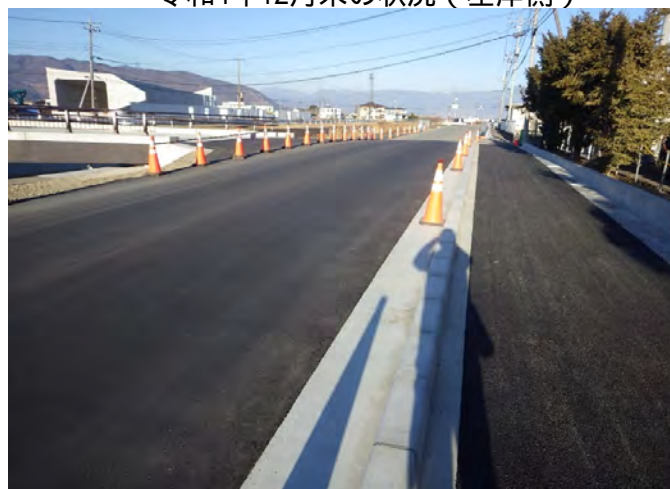
令和4年12月末の状況（左岸側）
