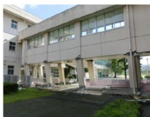
渡り廊下東棟の外観
