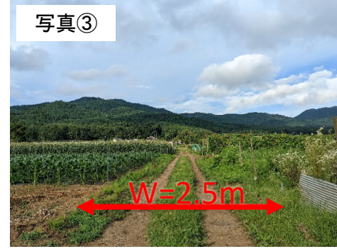
写真③ 一部の農道では幅員が狭く、すれ違いが困難であり、通作や営農に支障をきたしている。
