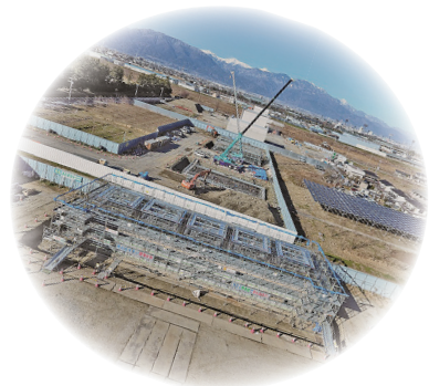
東油川高架橋 ～架設を待つ下部工たち～
