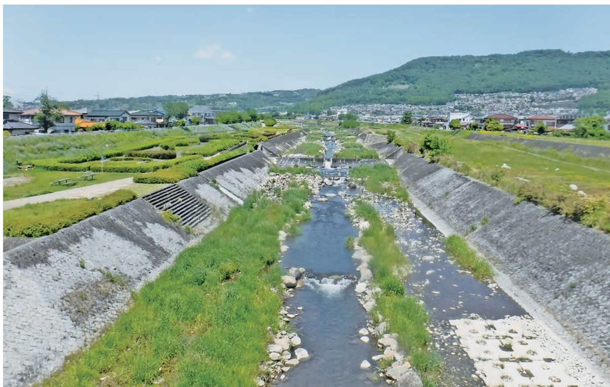
荒川千松橋上流
