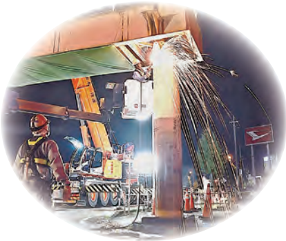
3位 歩道橋撤去
