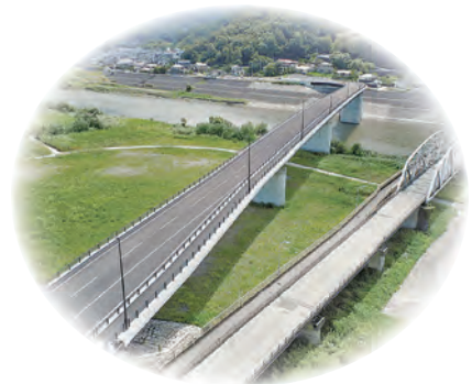
3位 「富士橋」竣工
