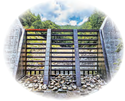
9位 日川(塩山)砂防堰堤改修工事
