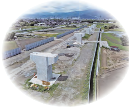
8位 国道140号橋梁下部工事
