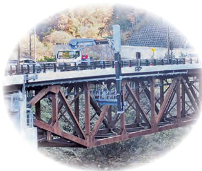
2位 中之倉バイパス橋の点検
