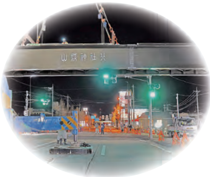
1位 歩道橋架設
