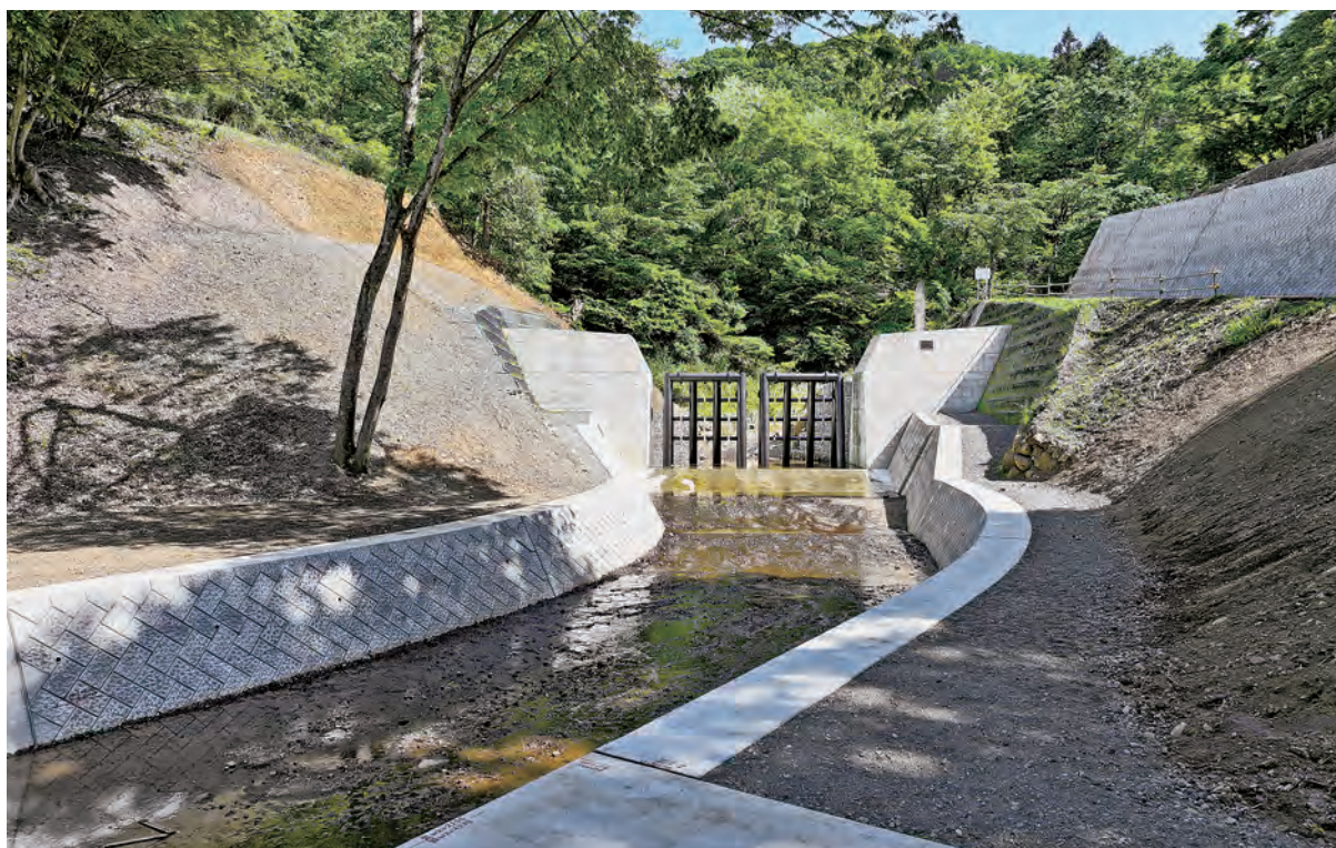
テントウ沢 砂防工事 (大月市)
