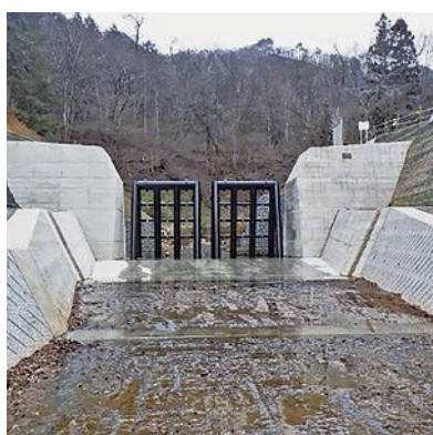
テントウ沢砂防工事
