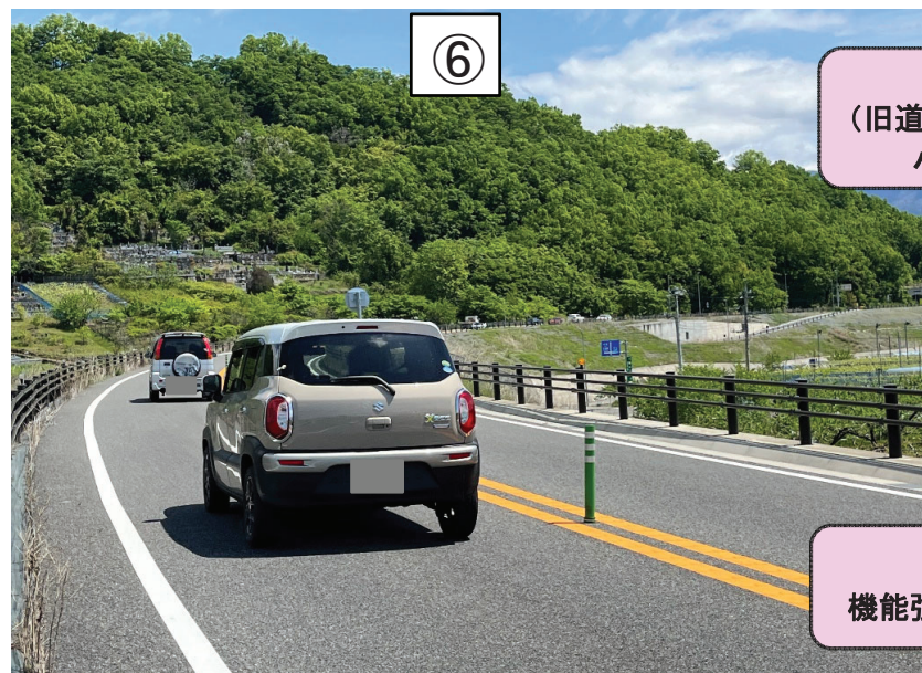
(バイパス) 山梨市北地内 八幡北ランプ付近
