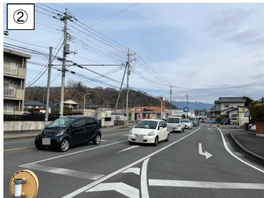
② (供用後) 山梨市万力地内 西関東道路入口交差点
