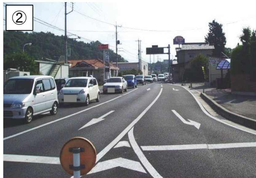
② (供用前) 山梨市万力地内 西関東道路入口交差点
