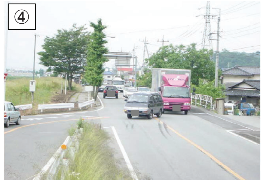
(供用前) 山梨市南地内 八幡橋西詰付近
