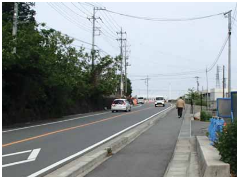
①歩道整備後の状況
