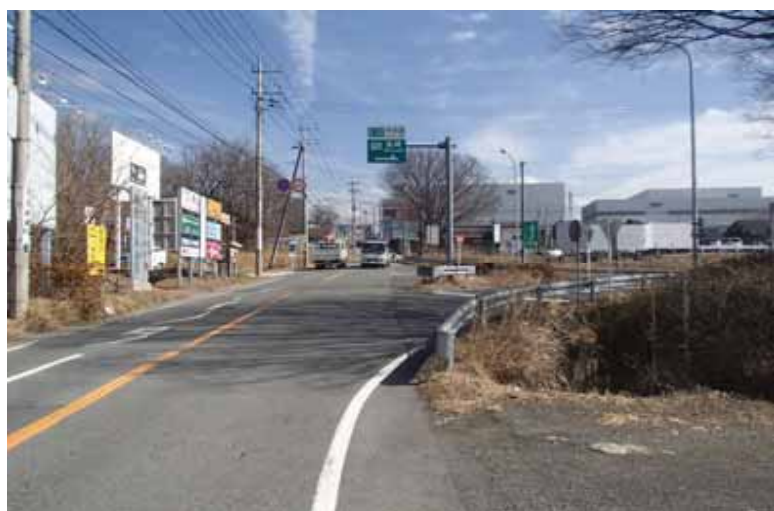
⑤ 葦崎インターチェンジ交差点付近の状況
