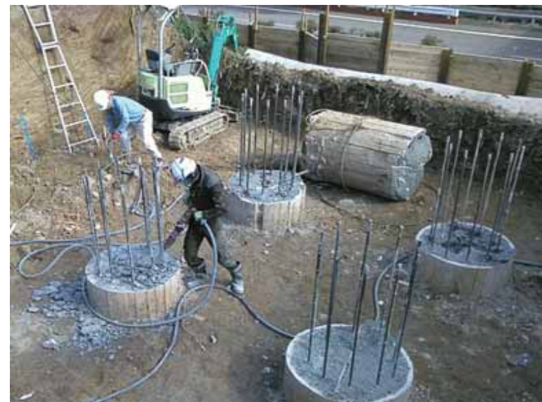
杭基礎設置状況
