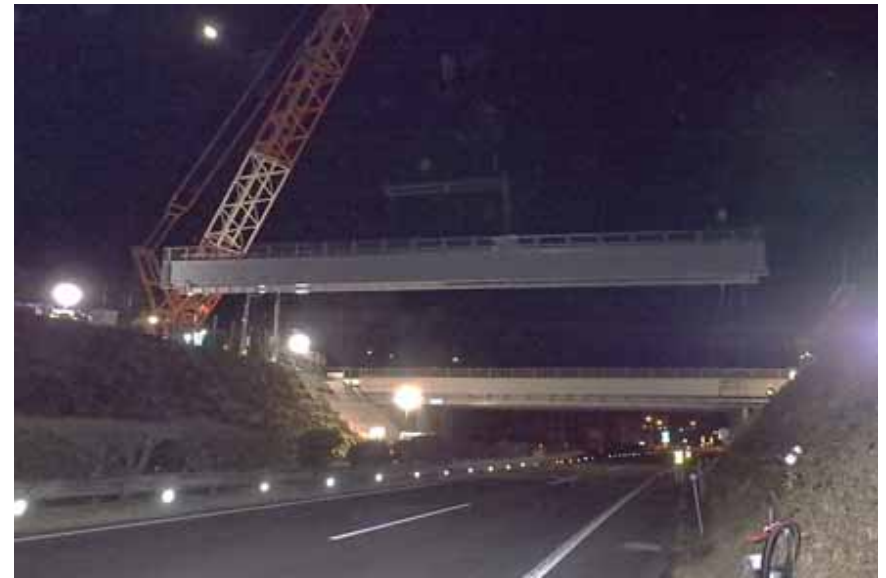
歩道橋の架設状況
