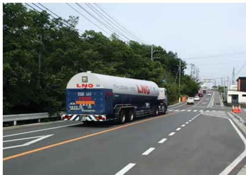
④幅員の確保により大型車の通行がスムーズに (整備後)
