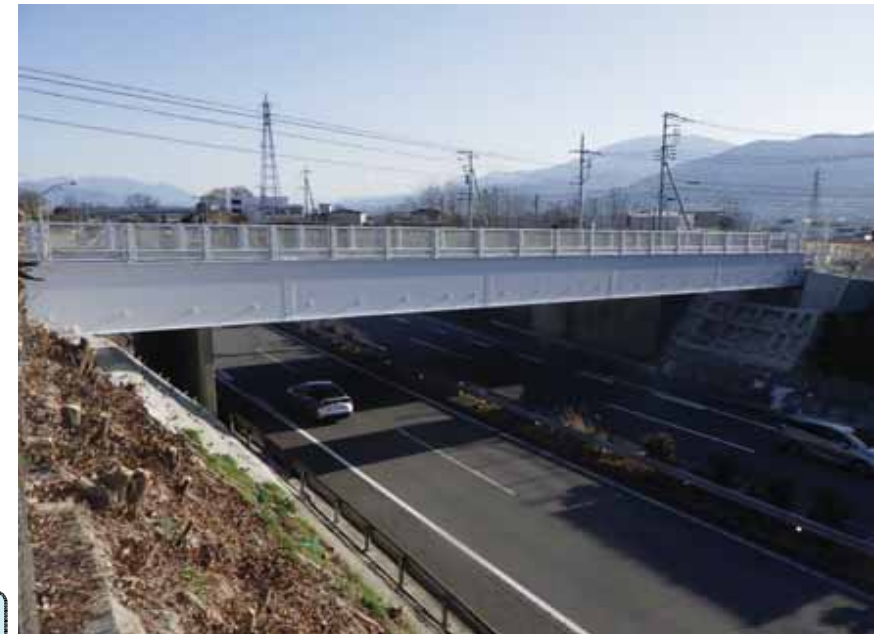
歩道橋設置状況
