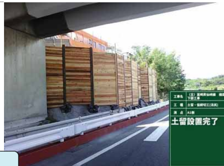
土留め工設置状況
