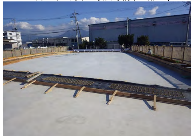
令和4年10月末の状況（橋梁上部工）
