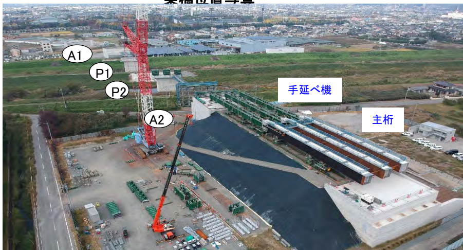
架橋位置写真
