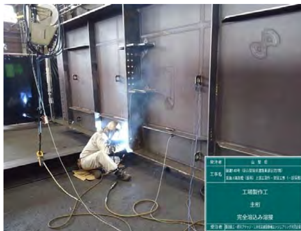
橋桁製作状況
