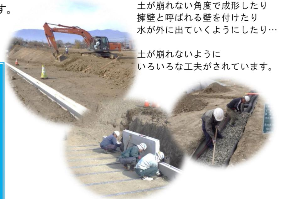
土が崩れない角度で成形したり擁壁と呼ばれる壁を付けたり水が外に出ていくようにしたり…
