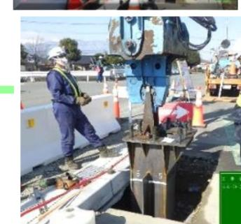
杭の上部を機械のアームで挟み、振動で杭を入れず、地層深くまでいきます。
