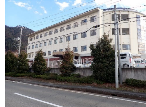
介護老人保健施設 (災害時要援護者関連施設)
