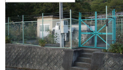
上水道施設 写真②
