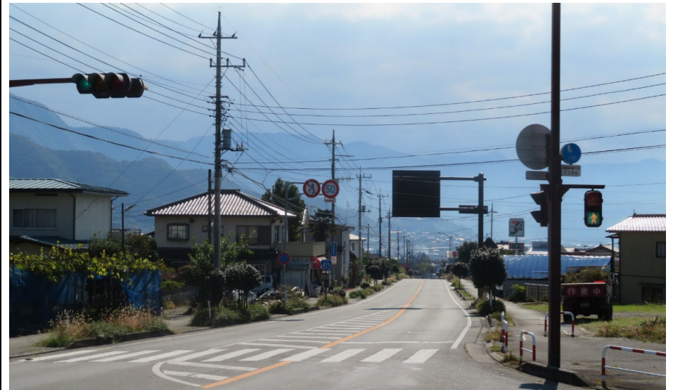
【写真②】 災害時に倒壊の恐れのある電柱
