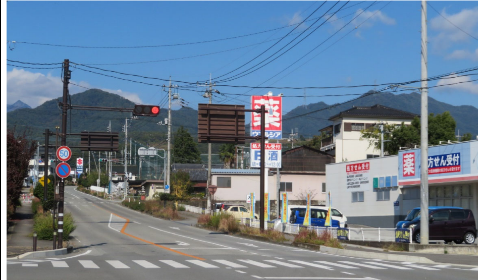
【写真①】 災害時に倒壊の恐れのある電柱
