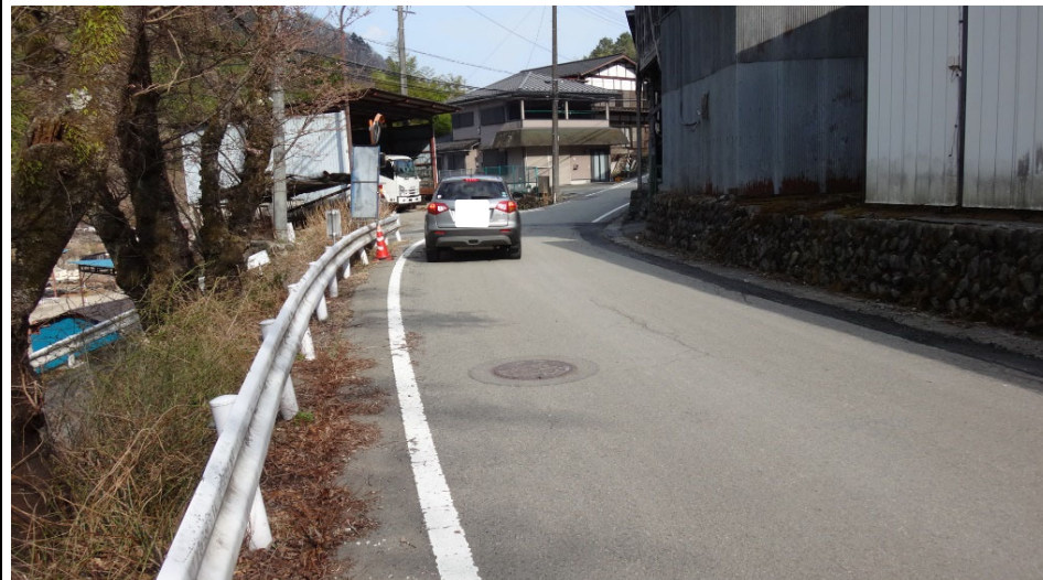
【写真①】線形・視距不良
