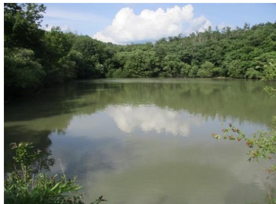
② 伊豆の宮ため池 全景 貯水量 30,000m 3 、堤高 H=7.2m
