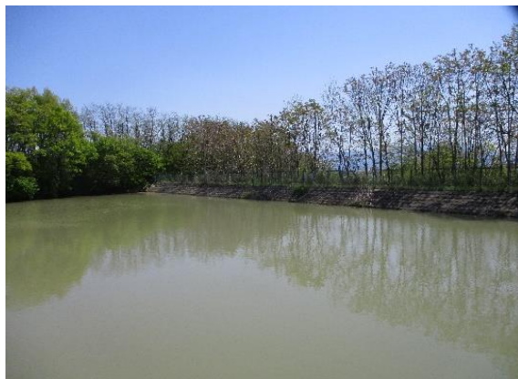
① 久保入ため池 全景 貯水量 15,000m 3 、堤高 H=8.8m
