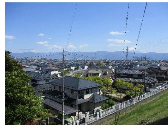
③ ため池下流には人家があり、大規模地震の際には甚大な被害のおそれがあるため、早急に対策を講じる必要がある。
