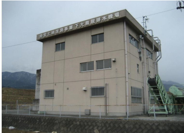
①下大鳥居排水機場の全景
