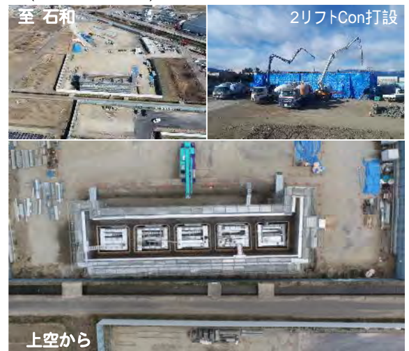
橋台-躯体工3リフト施工状況(ドローン空撮)
