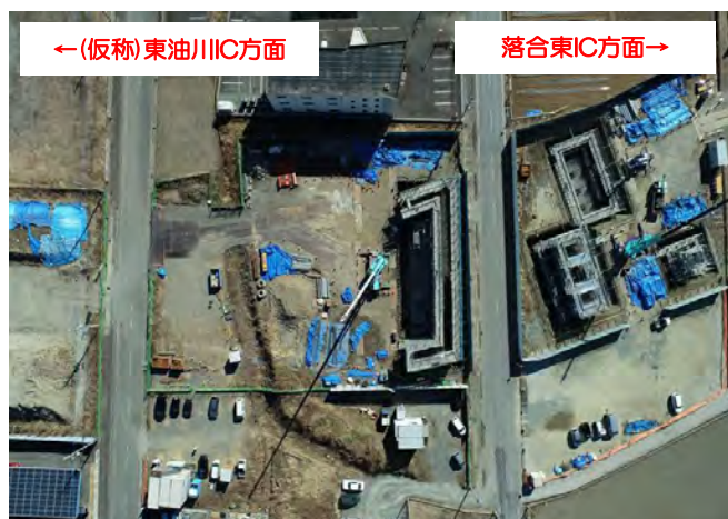
[上空からの全景]
