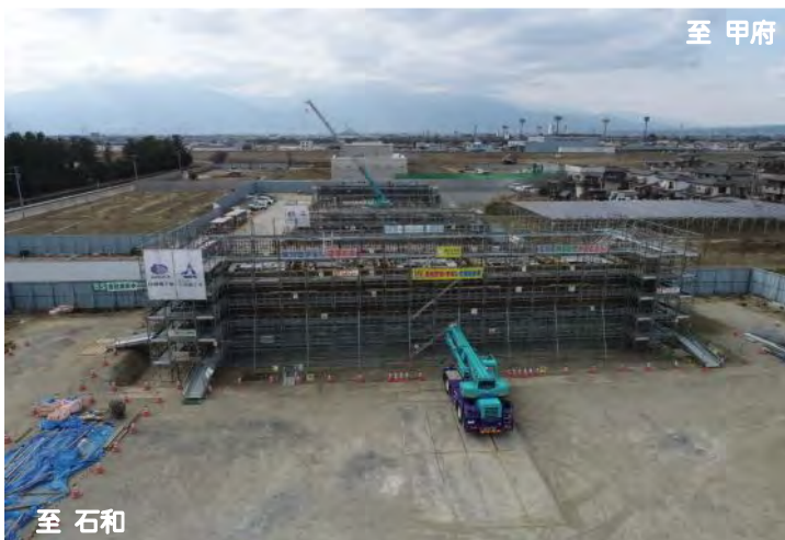
橋台-躯体工3リフト施工状況(ドローン空撮)
