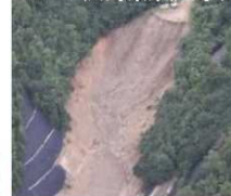
廃棄された土石の崩落 死者1名、重傷者1名、家屋被害1棟
