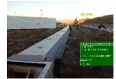
側溝布設完了
