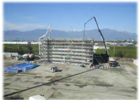
5回目のコンクリート打設状況
