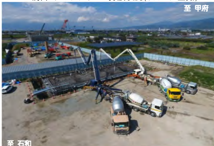
橋台-フーチングCon打設状況(ドローン空撮)
