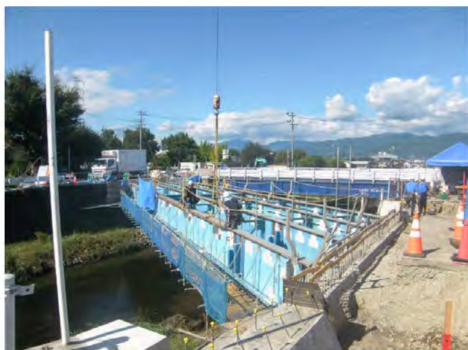
フィラープレート設置状況
