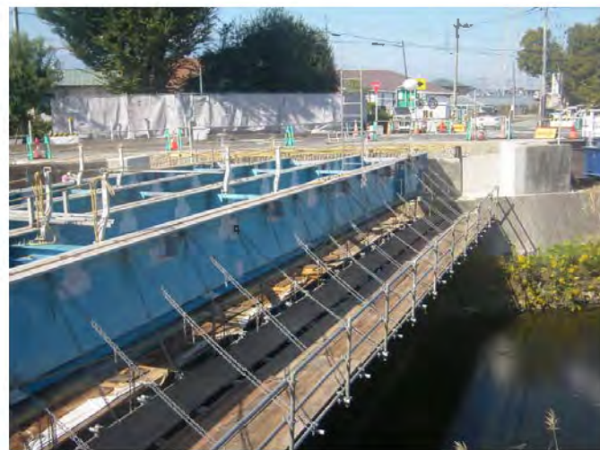
既設擁壁改良復旧完了
