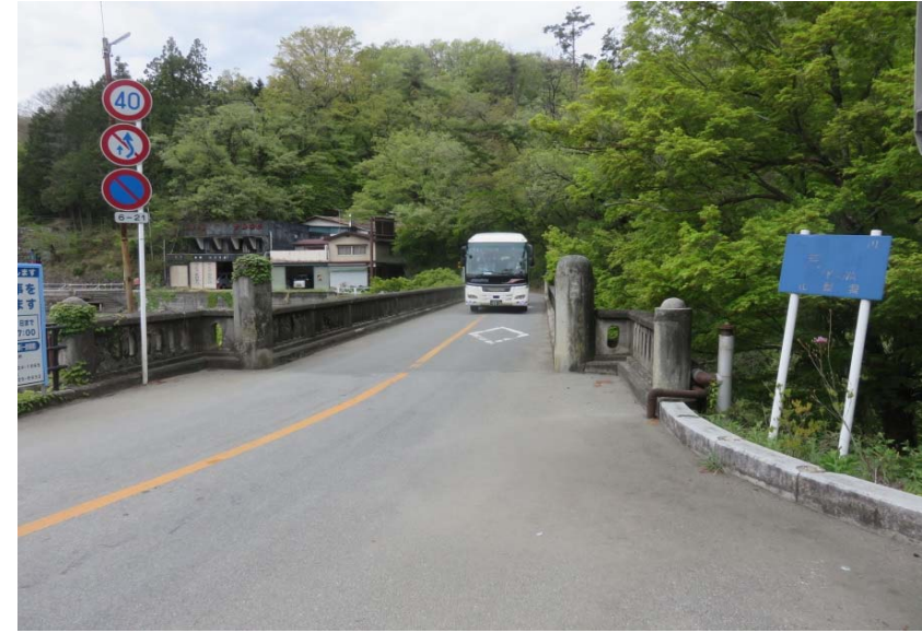
②現橋幅員状況（幅員狭小、歩道無し）
