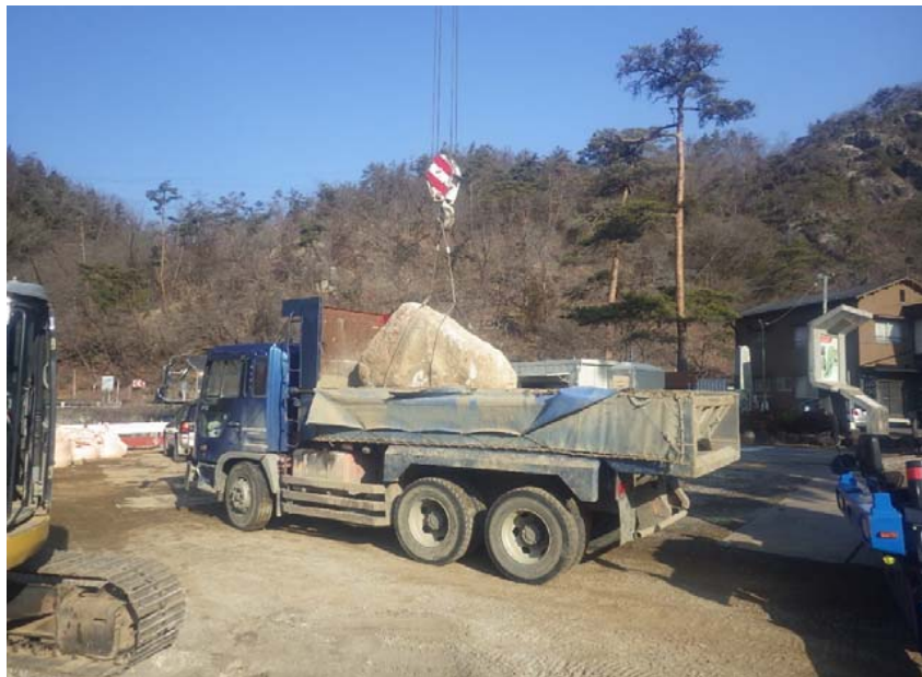
⑦巨石転石運搬状況
