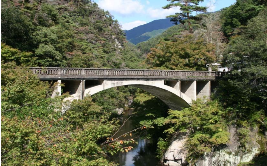
①長潭橋（現橋）
