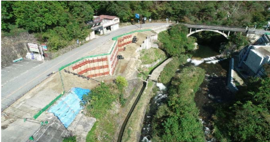
⑥工事施工中写真
