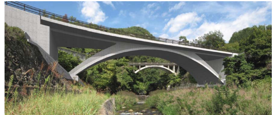
④工事完了イメージ写真
