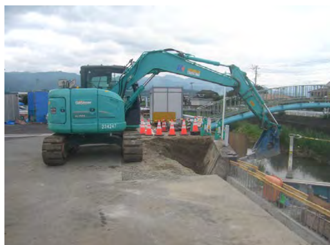
既設擁壁撤去状況
