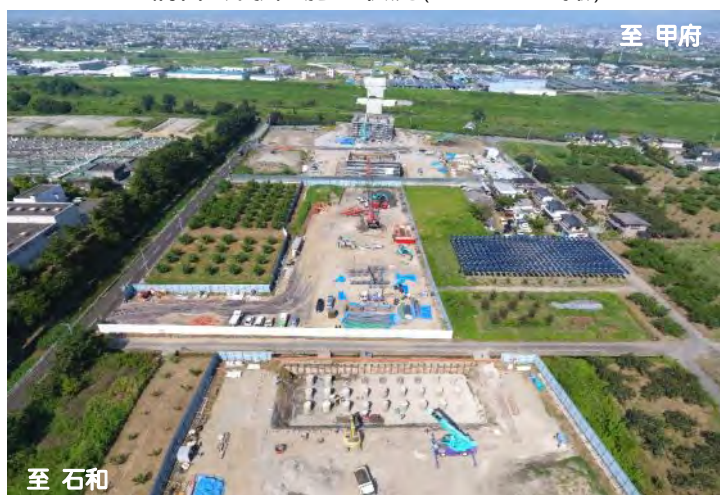
橋台-床掘り施工状況(ドローン空撮)
