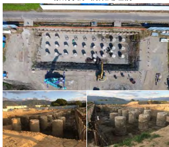
場所打杭-杭頭処理前
