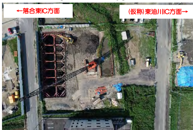
[上空からの全景]
