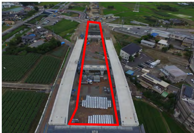
架橋位置写真
