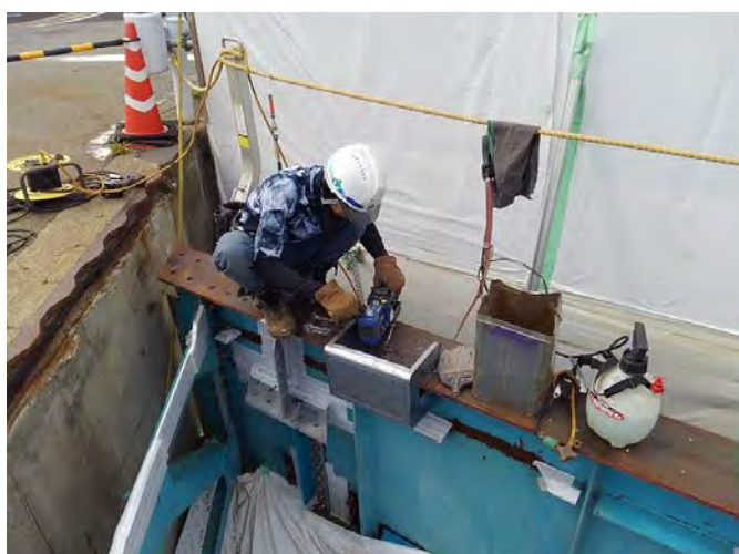
ボルト孔削孔状況
