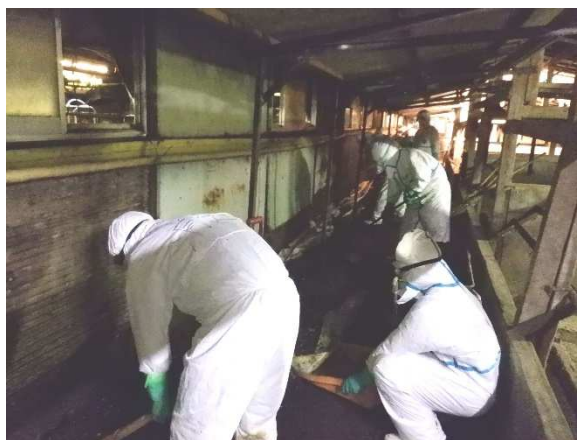
《汚染物品処理作業》
