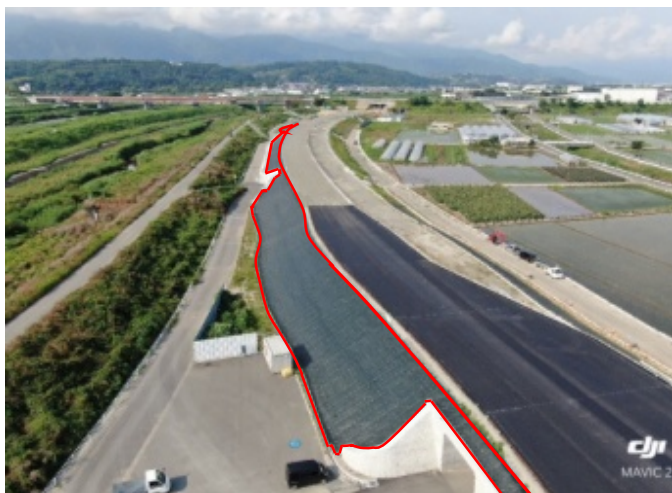
防草シート 施工済み
