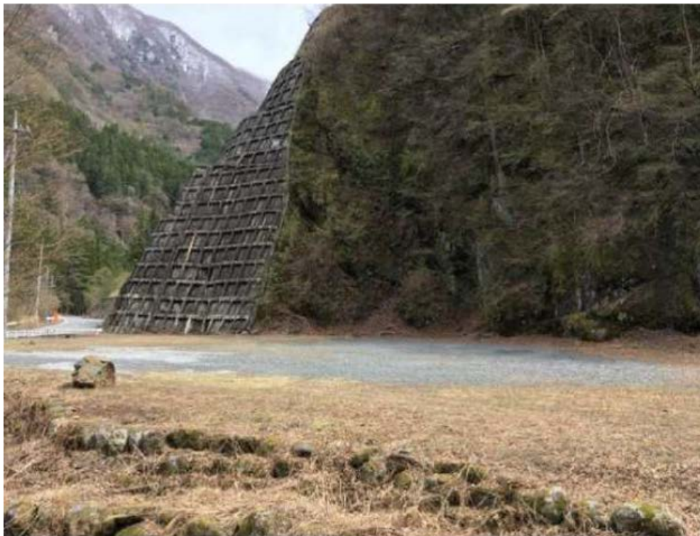
写真 2-1 湯島地区発生土仮置き場計画地の現況
