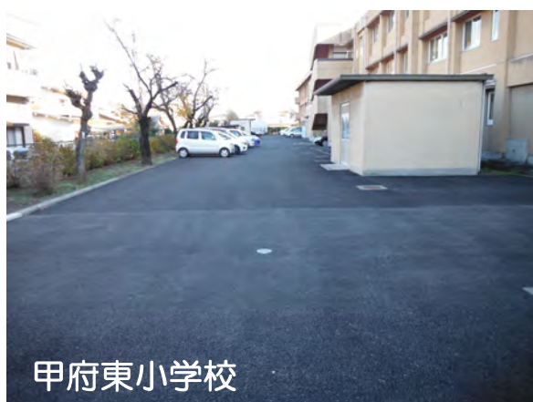
駐車場透水性舗装事例（甲府東小学校・甲府東高校）
