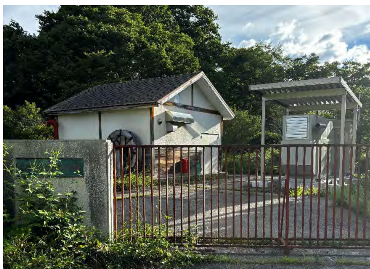
尾鼻污水中継ポンプ場
