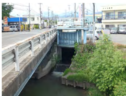
鎌田川第 2 排水樋門
