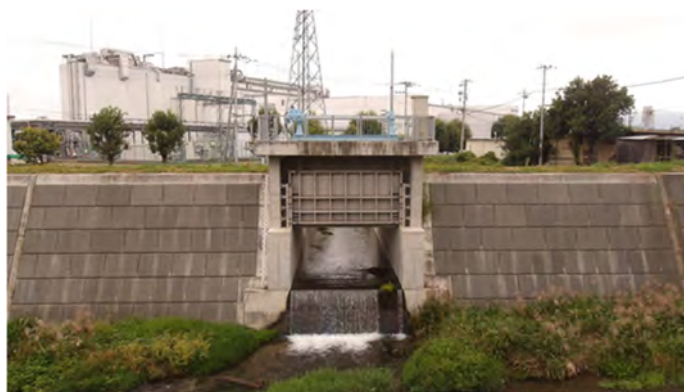
鎌田川 4.9k 樋門
