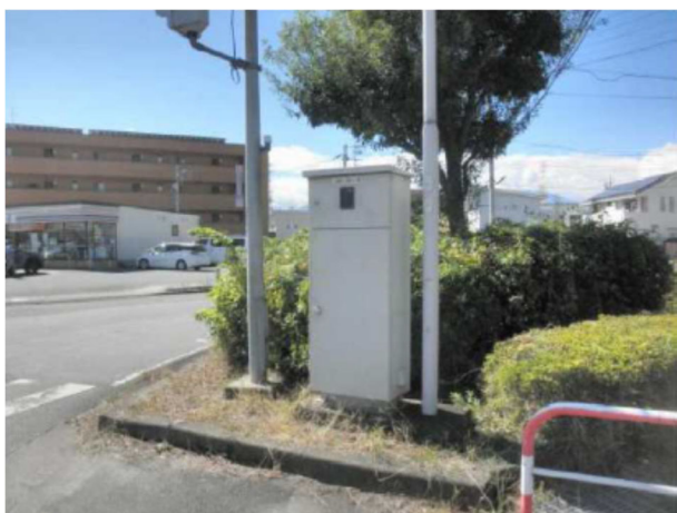
大里第一マンホールポンプ場
