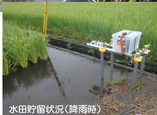
写真 4.5② 田んぼダムの取り組み（南アルプス市における実証実験の様子）
