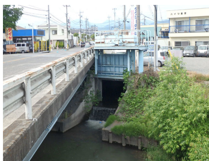
鎌田川第 2 排水樋門
