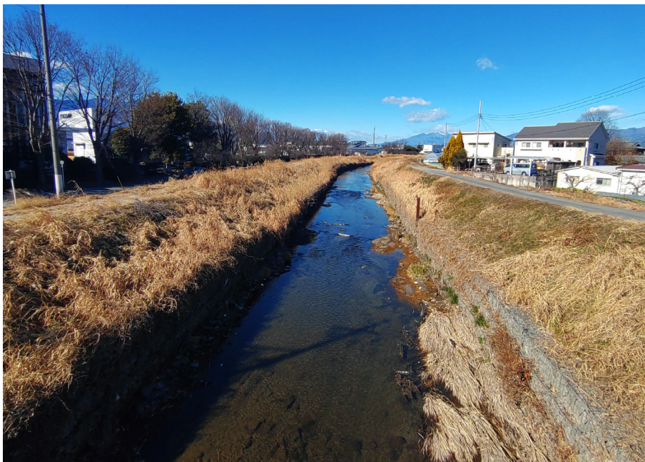
写真 3.2① 鎌田川一部改修区間(高室橋上流)
