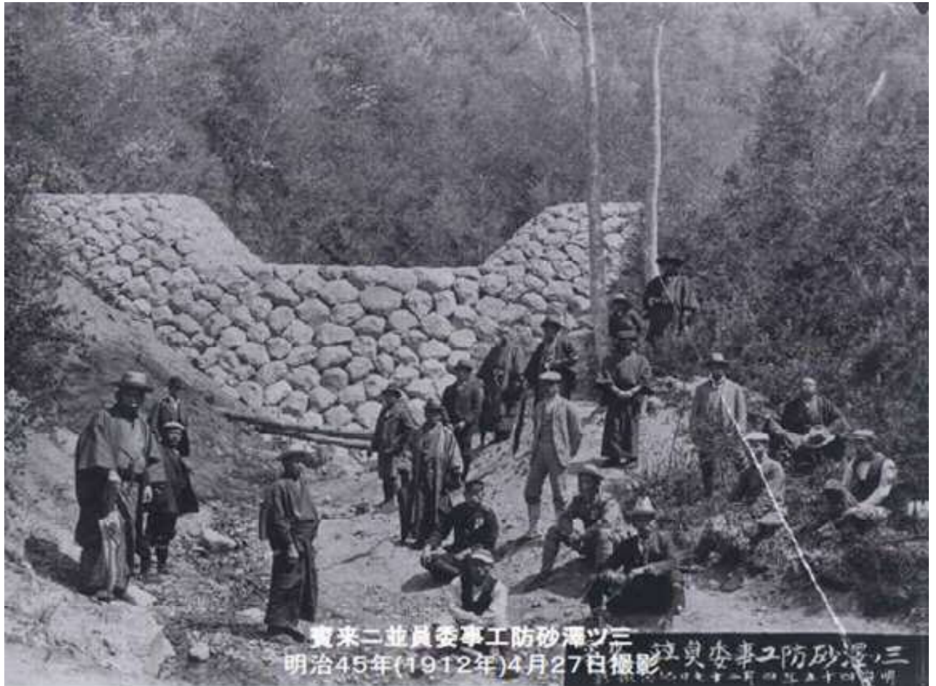
明治45年谷止工完成当時の写真
