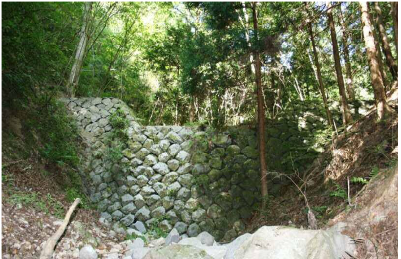
現在の谷止工の状況写真
