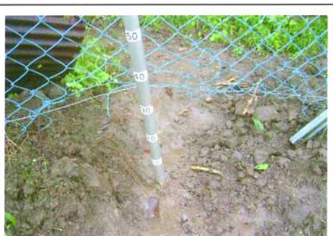
(写真4) イノシシに持ち上げられ、30cm以上の隙間ができた柵。
