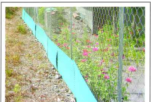
(写真3) 柵の外側からトタンを追加設置している。イノシシの目隠し効果もある。
