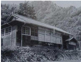
88年に増築された校舎...ほだぎより
