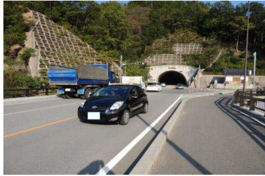
供用状況 波高島トンネル付近
