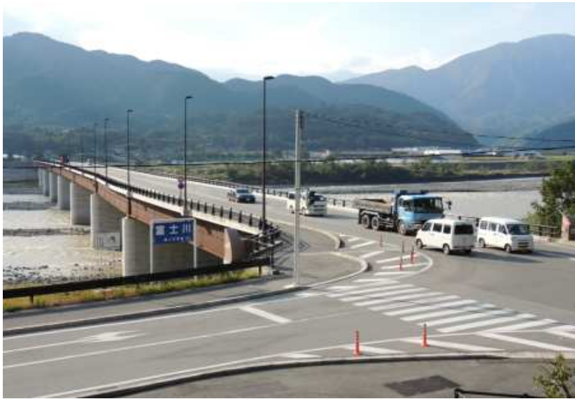
供用状況 富山橋東詰付近
