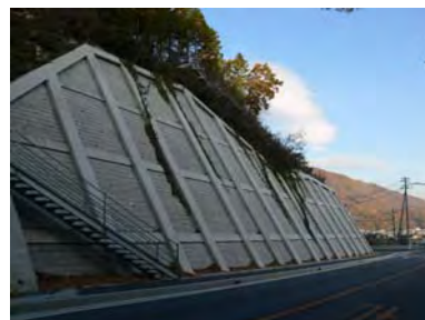
一般国道 52 号 現場打法枠
