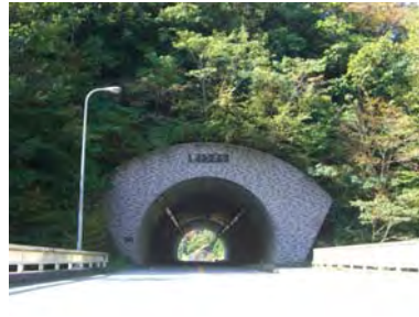
一般国道 300 号 面壁型坑口部
