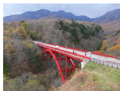
主要地方道 北杜富士見線
