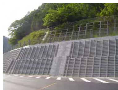
一般国道 358 号 井桁組擁壁
