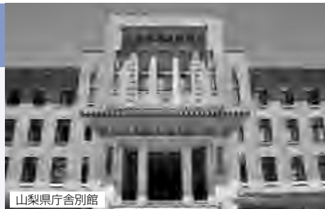
山梨県庁舎別館
