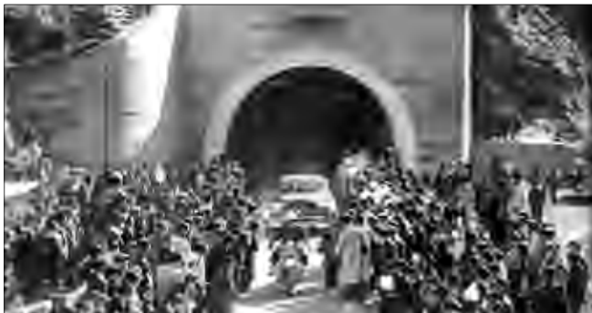
新笹子トンネル開通
