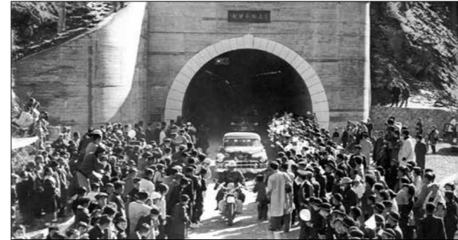
新笹子トンネル開通
