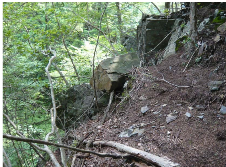
④ 現道路側 擁壁基礎抜け落ち状況
