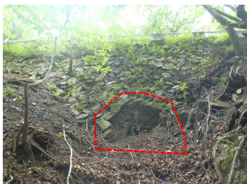
④ 現道路側 擁壁基礎抜け落ち状況
