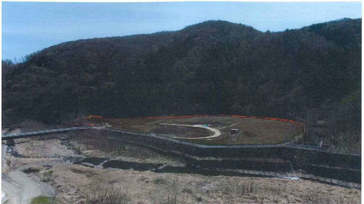
造成工事着工時撮影
