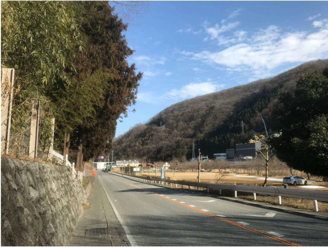
国道 20 号沿道東京から 104. 5km 地点からの写真
