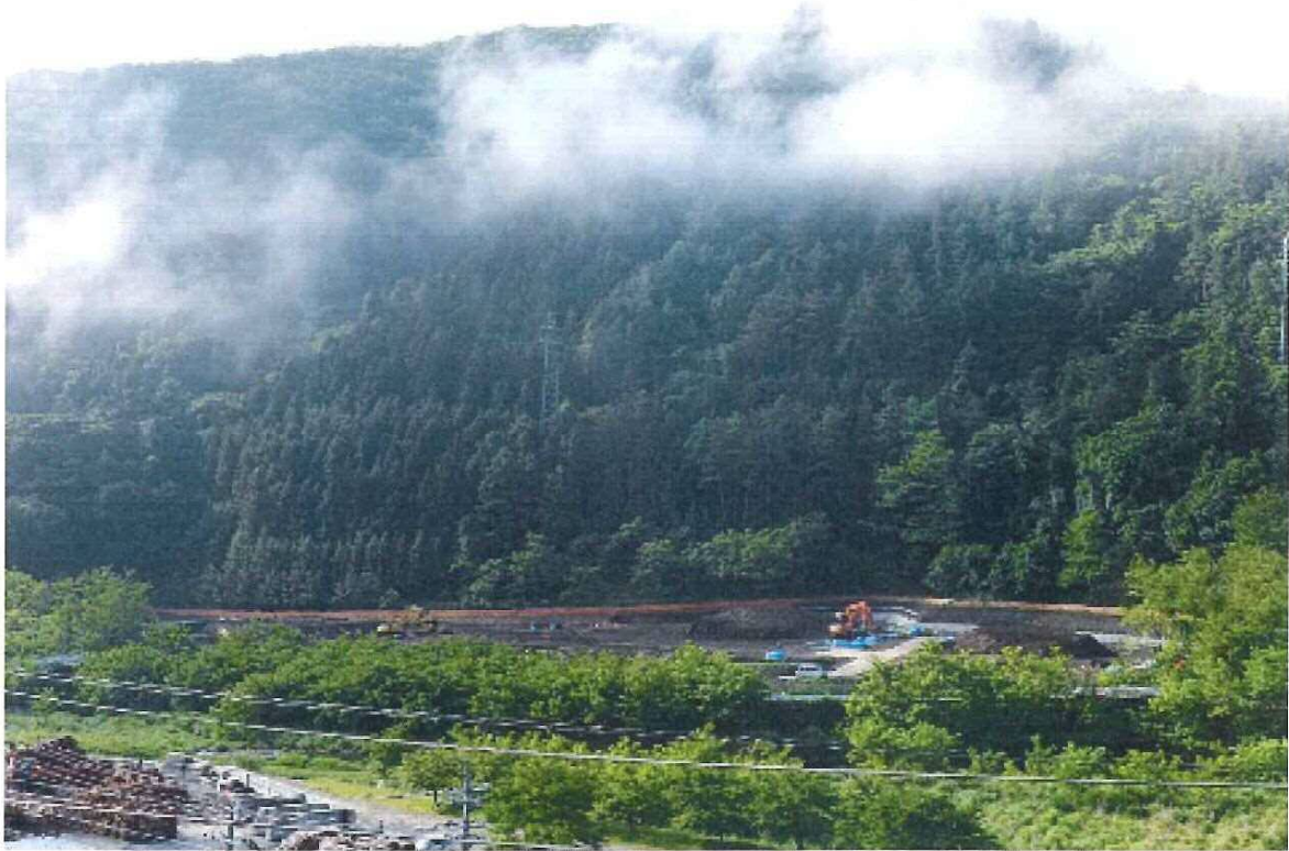
造成工事中撮影
