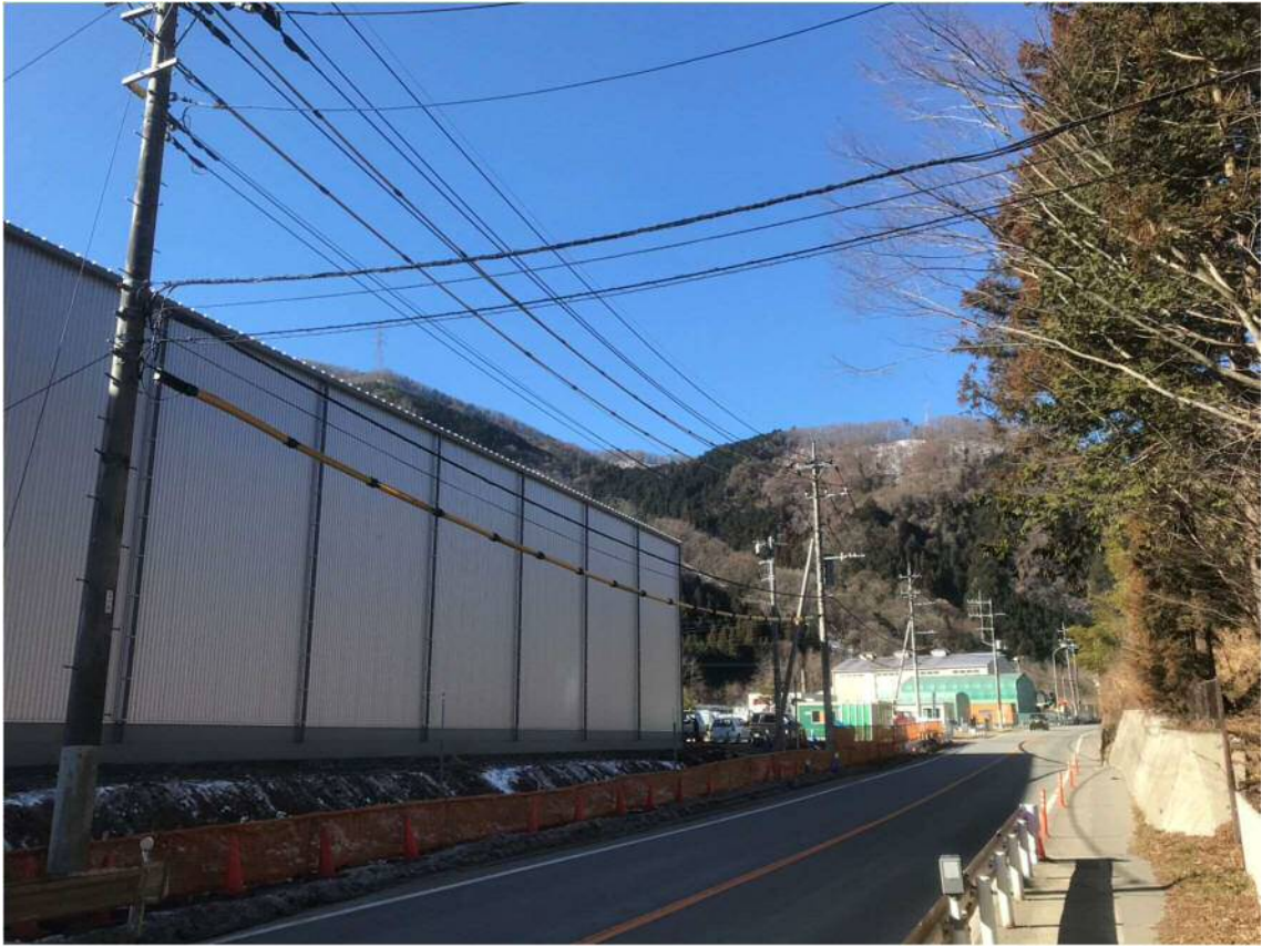
国道 20 号沿道東京から 104. 0km 地点からの写真
