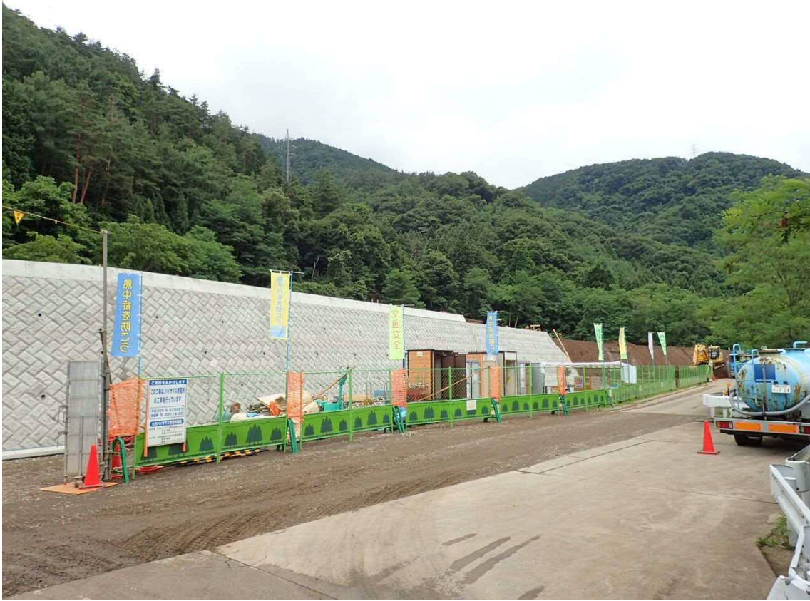
車両では入口付近の路面散布
