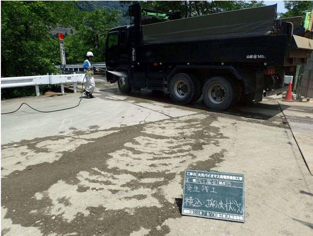
残土運搬トラックのタイヤを洗う写真
