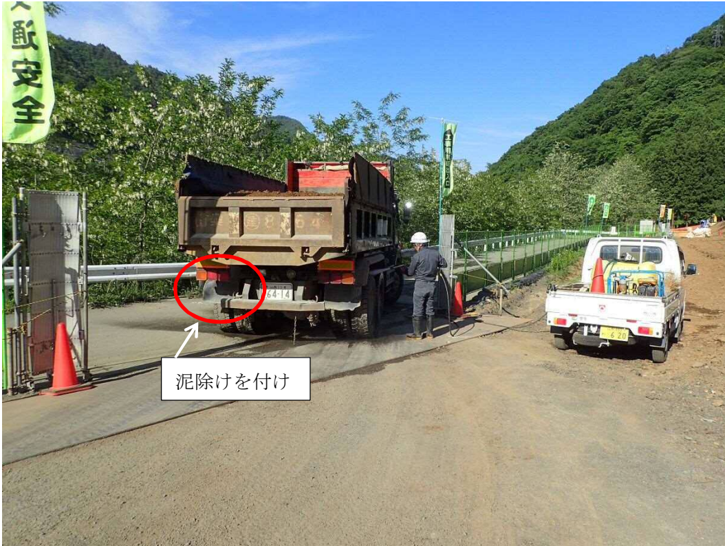
残土運搬ダンプのタイヤを洗っている写真
