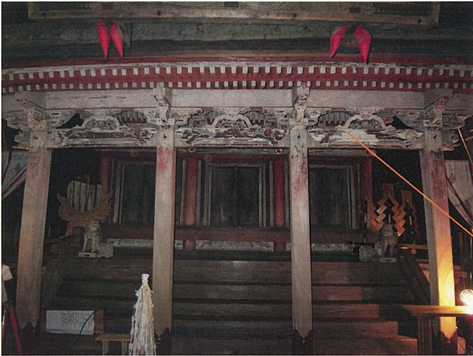
本殿向拝 (正面)
