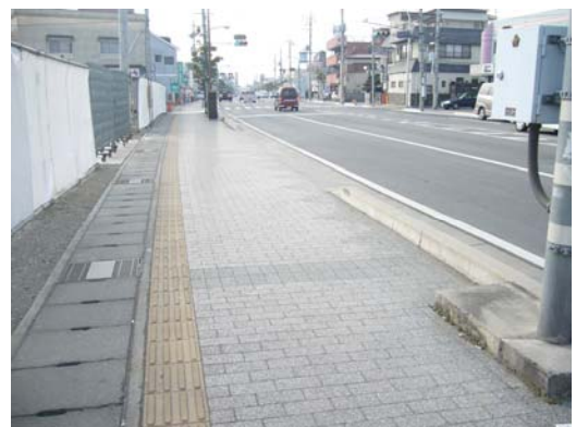
フラットで広い歩道
